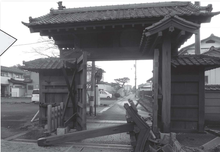
二月十三日の福島県沖地震により、山門の一部が倒壊した
